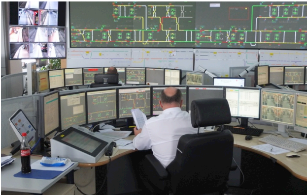
Bild 1: Arbeitsplatz in der Leitstelle der VAG Nürnberg (Quelle: VAG Nürnberg, 09/2014)
