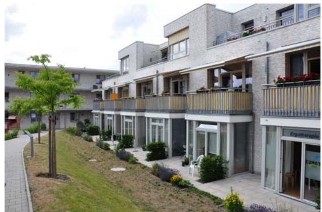
Bild 3 Stiftungsdorf Arberger Mühle. Neubau "Wohnen mit Service" (Foto: H. Engelen)
