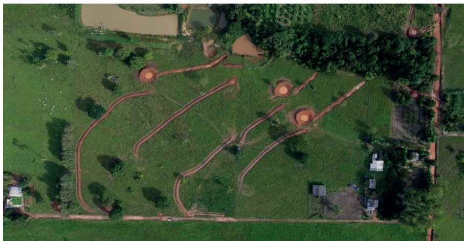
Figura 6 - Imagem aérea da Unidade Demonstrativa Chácara São José, reunindo diferentes engenharias de conservação do solo e da água em Juína-MT.
