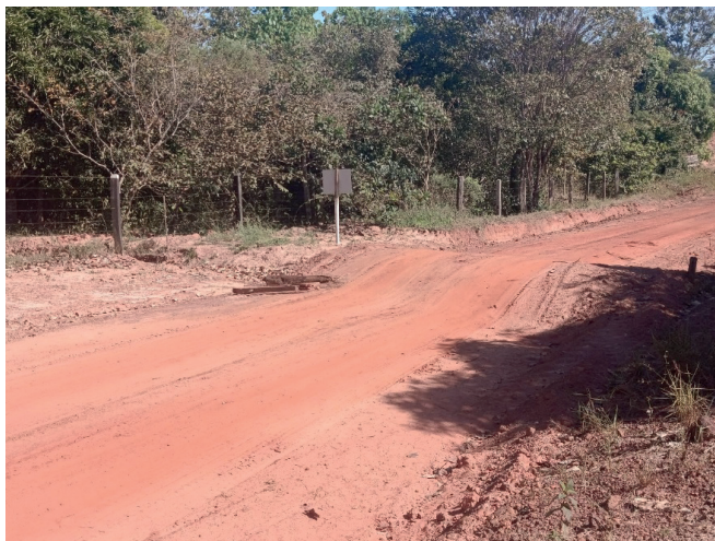
Figura 4 - Estrutura de lombada drenante utilizada para interceptar o fluxo superficial concentrado na estrada e direcioná-lo de forma controlada para áreas adjacentes de infiltração.
