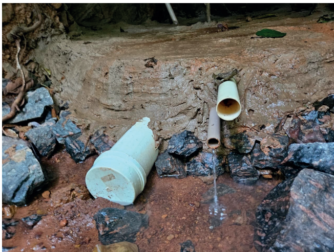
Figura 5 - Água emergindo de forma límpida após a implantação do caxambu na Chácara São José, evidenciando a eficiência da estrutura na retenção de sedimentos provenientes da estrada vicinal.
