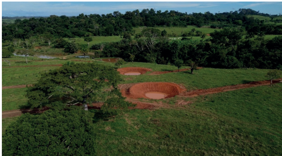
Figura 2 - Sequência de barraginhas implantadas ao longo da catena do terreno na Chácara São José (Juína-MT), promovendo a retenção do escoamento superficial, a infiltração de água no solo e a recarga dos aquíferos locais.
