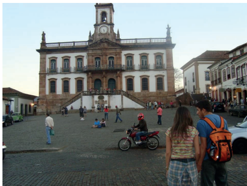
Figura 2.4 | Edificação no centro de Ouro Preto/MG
