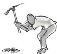
1. Cava dos huecos de 18 pulgadas (45 cm) de profundidad y 2 pies (66 cm) de ancho
