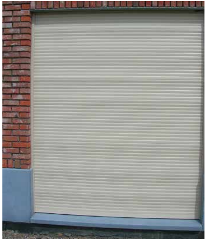
Bild 4: Welligkeit von Rollladenpanzern
