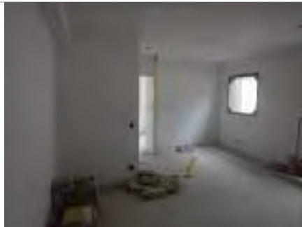
Vista da unidade
