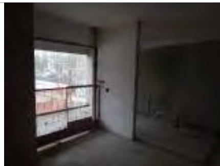
Vista da unidade
