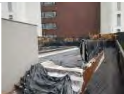
Piscina (em construção)
