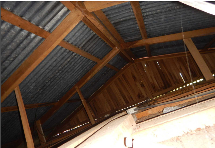
Descripción: Espacio entre cielorraso y techo y en esta parte parcialmente entubado
