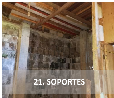
19. SOPORTES EN MAL ESTADO
