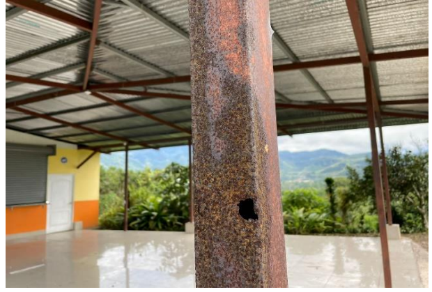
Columnas en mal estado, mucho óxido
