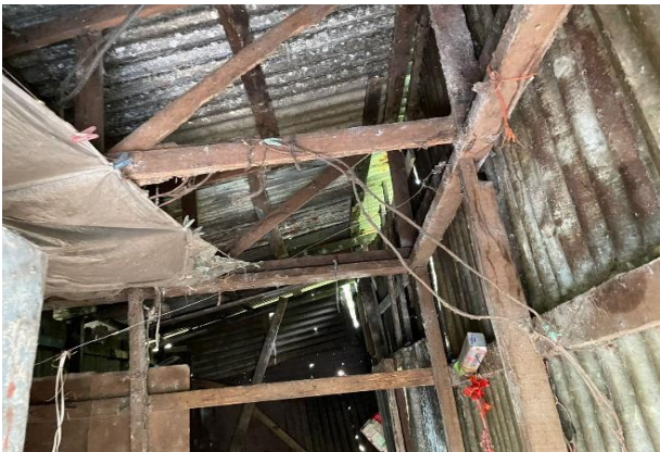
Bodega, por estado y materiales se considera para demolición
