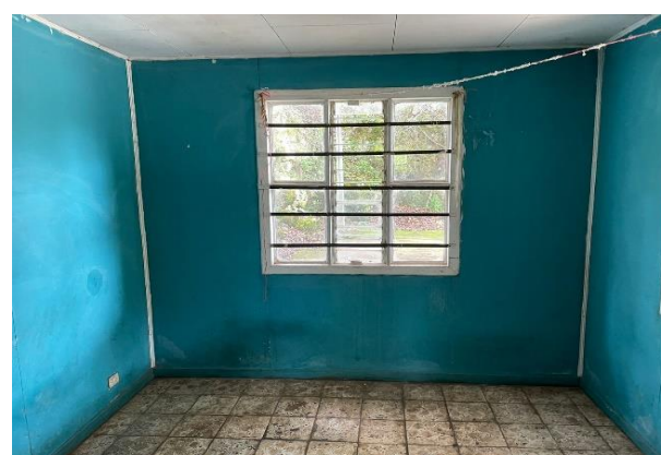
Dormitorios - problemas de humedad en paredes, cielos y pisos
