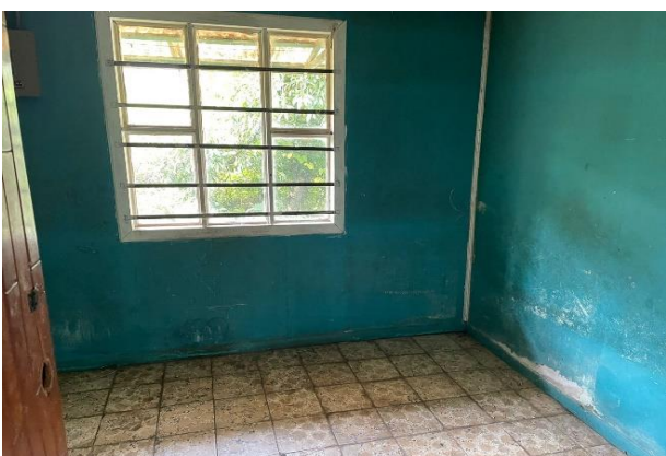
Dormitorios - problemas de humedad en paredes, cielos y pisos
