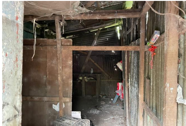
Bodega, por estado y materiales se considera para demolición
