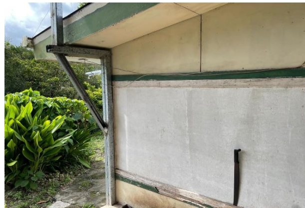
Sistema eléctrico sin entubar
