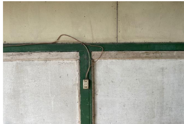
Sistema eléctrico sin entubar
