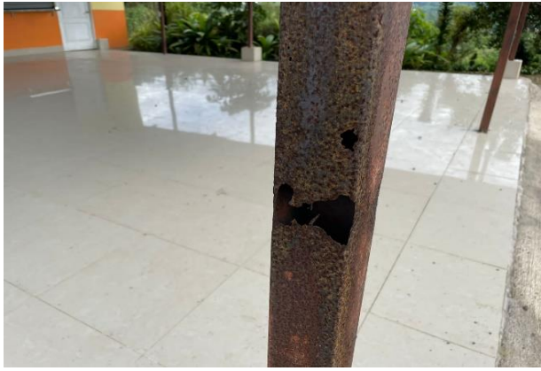
Columnas en mal estado, mucho óxido
