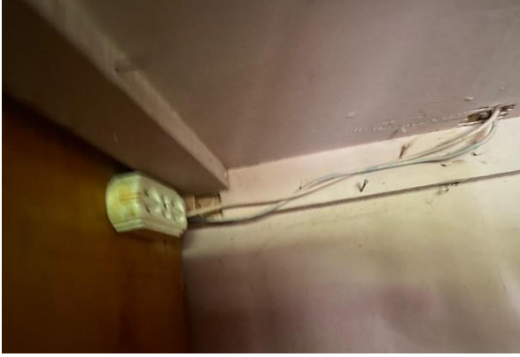
Cableado expuesto en tomacorriente
