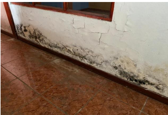
Humedad en las paredes, repellos agrietados
