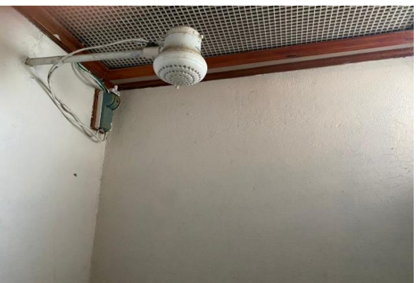
Baño - cuchilla y cableado sin entubar en la termoducha
