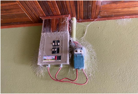
Centro de carga, cuchilla y cableado sin entubar
