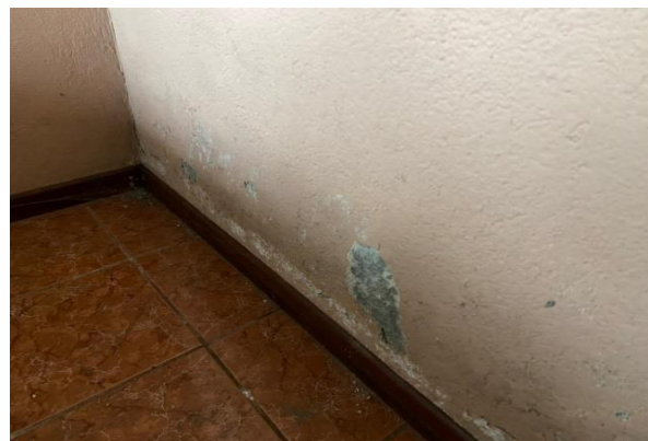
Humedad en las paredes, repellos agrietados
