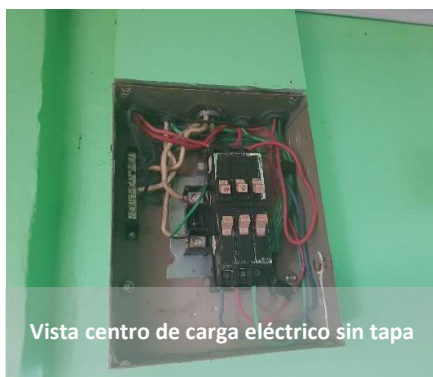
Vista conexiones eléctricas expuestas
