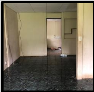
Acabados / piso ceramica/ cielos fibrolit/ paredes prefabricadas
