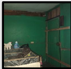
Cuarto pilas en madera vieja estado MM
