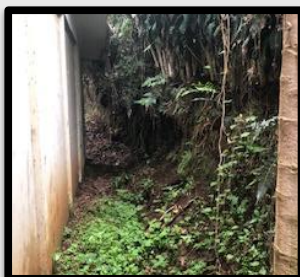
Talud sobre el lindero 2-3
