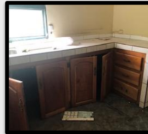
Mueble en concreto armado enchapado / paredes en fibrolit
