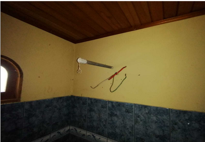
Descripción: Detalle de niple para conexión de ducha en baño de dormitorio principal.
