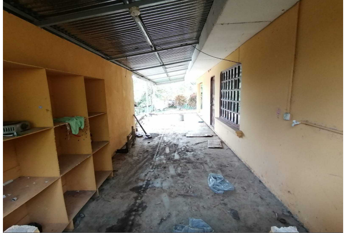
Descripción: Corredor posterior y área de pilas. Piso en concreto, sin cielo.
