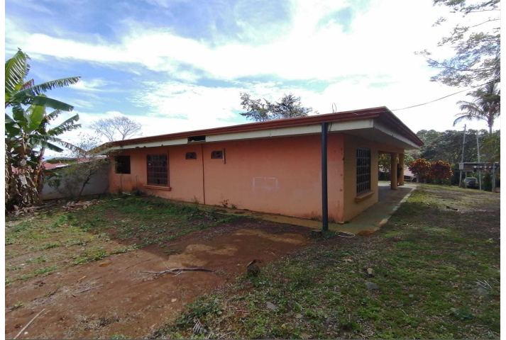
Descripción: Fachada oeste.
