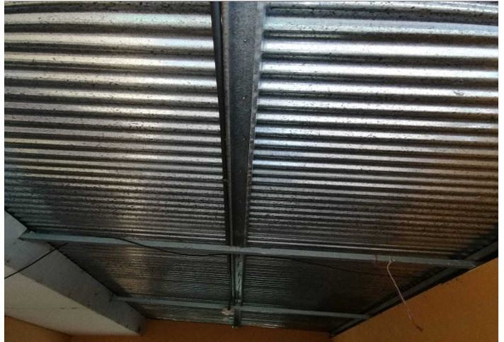
Descripción: Detalle de la estructura de techo en tubo de hierro, en el área de pilas.
