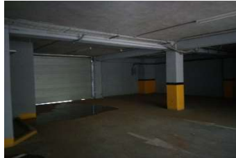
Parqueo 1er nivel, charcos y pared de recepción con humedad
