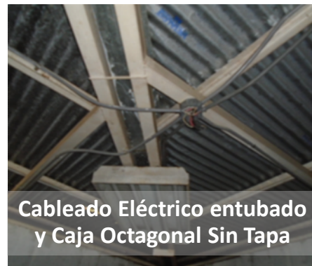
Cableado Eléctrico entubado y Caja Octagonal Sin Tapa
