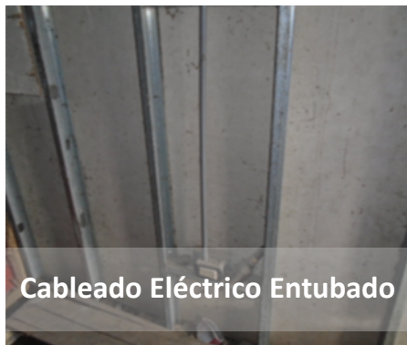
Cableado Eléctrico entubado y Caja Octagonal Sin Tapa
