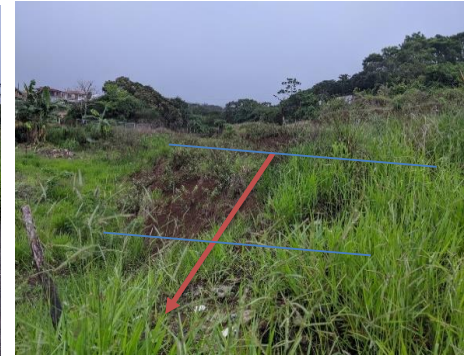
VISTA TALUD ENTRE
