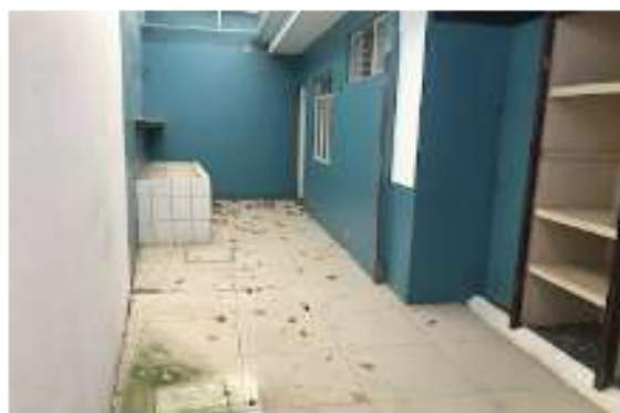
Parte de Pila s
