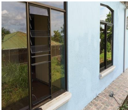
Vista parcial lateral de la vivienda
