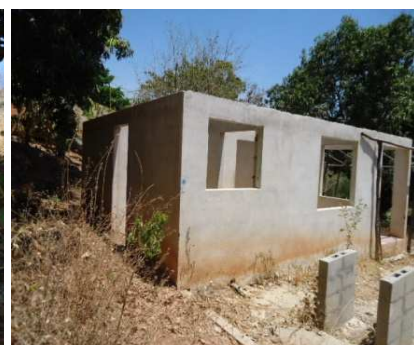
Construcción vista lateral
