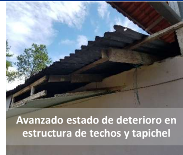
Avanzado estado de deterioro en cubierta de techos
