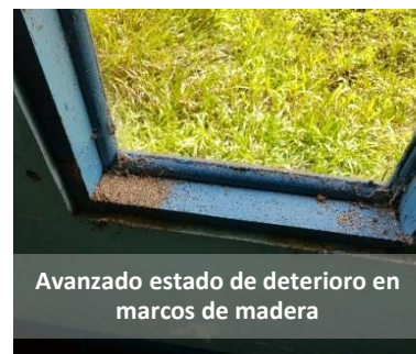
Avanzado estado de deterioro en marcos de madera
