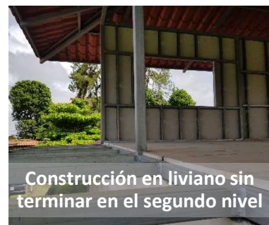
Construcción en liviano sin terminar en el segundo nivel
