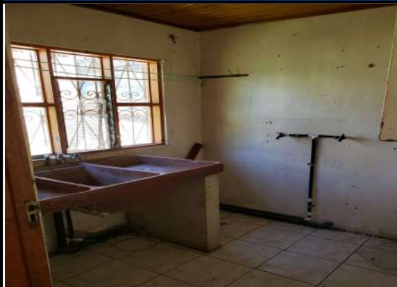
CUARTO DE PILA
