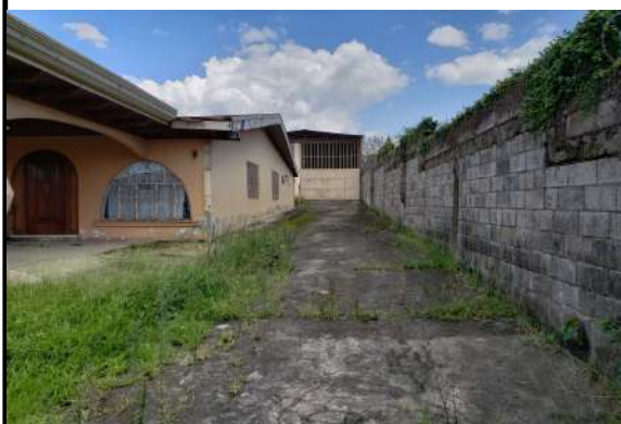
VISTA INTERNA DE LA PROPIEDAD
