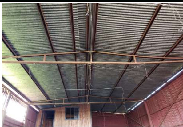
DETALLE DE LA BODEGA
