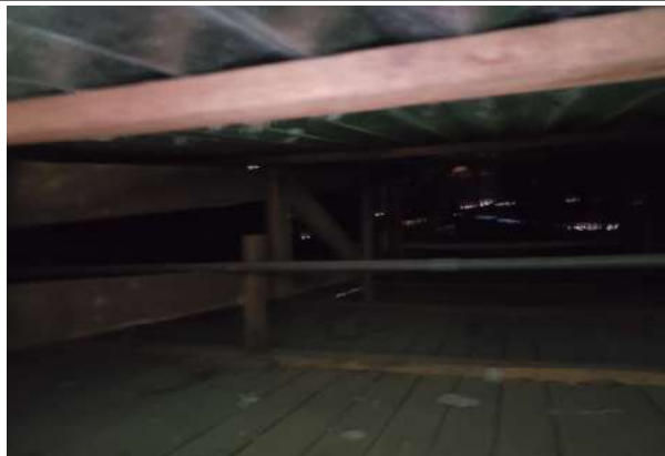
SISTEMA ELECTRICO ENTUBADO
