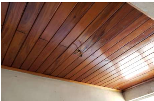
CIELO RASOS SIN LUMINARIAS
