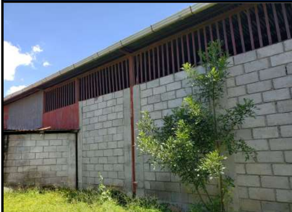
VISTA EXTERIOR DE LA BODEGA
