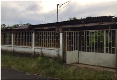
Figura 9. Vista general de estructura
