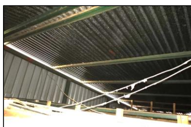
VISTA ESTRUCTURA DE TECHO Y ENTUBADO
