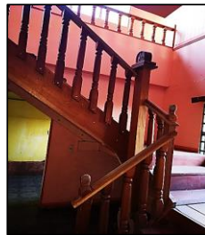
VISTA DE LAS ESCALERAS
