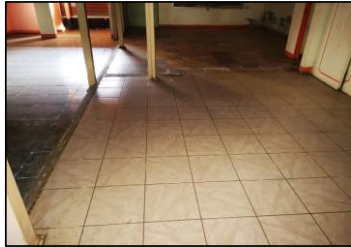
VISTA ACABADO DE PISO
