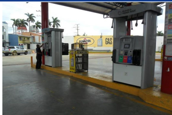
Mangueras separadas de los equipos
