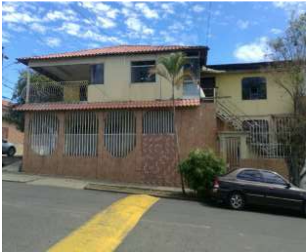
VISTA OESTE (FRENTE PRINCIPAL)
