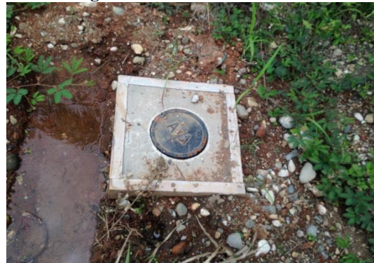
Medidor agua instalado
