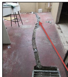
VISTA TUBERIAS ABIERTAS EN TENDIDO
