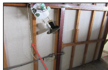
VISTA CABLEADO EXPUESTO
