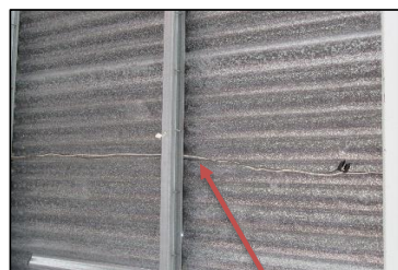
VISTA CABLEADO EXPUESTO
