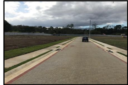
ACCESO Y ENTORNO
