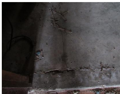
GRIETAS EN PISO CONCRETO
