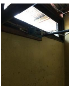
Termoducha e interruptor en baño
