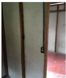
Paredes a un forro y detalles eléctricos
