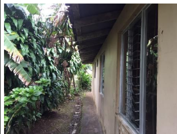
7. Costado de la vivienda
