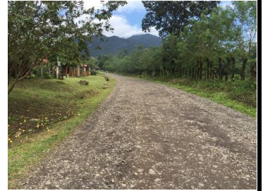
3. Calle de acceso
