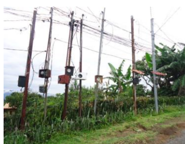
medidores eléctricos en entrada de servidumbre, medidor de agua de vivienda valorada
