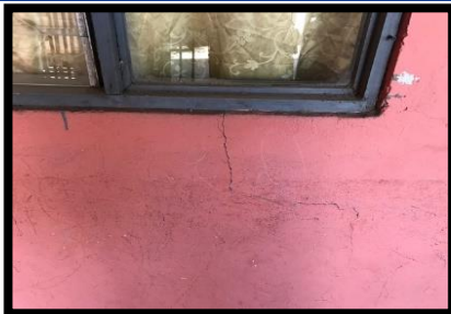
FISURAS EN PAREDES EXTERNAS
