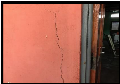
FISURAS EN PAREDES EXTERNAS
