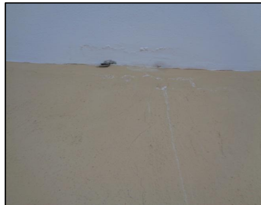
Deterioro observado en cielos
