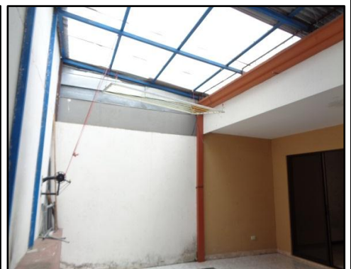
Patio posterior techado
