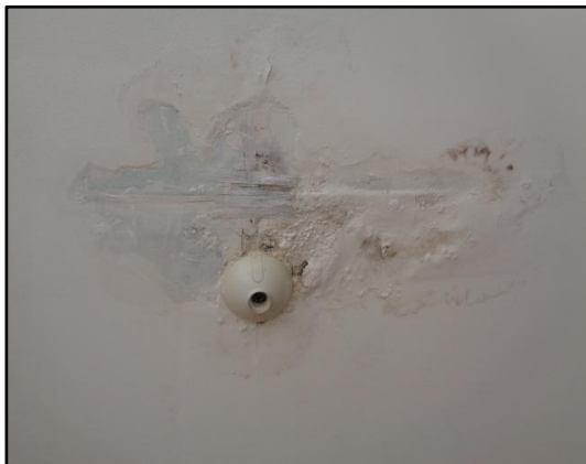
Deterioro observado en cielos
