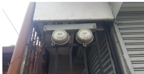
Medidores eléctricos instalados.
