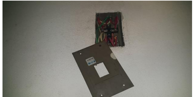
Vista de restos de la Caja de breaker.
