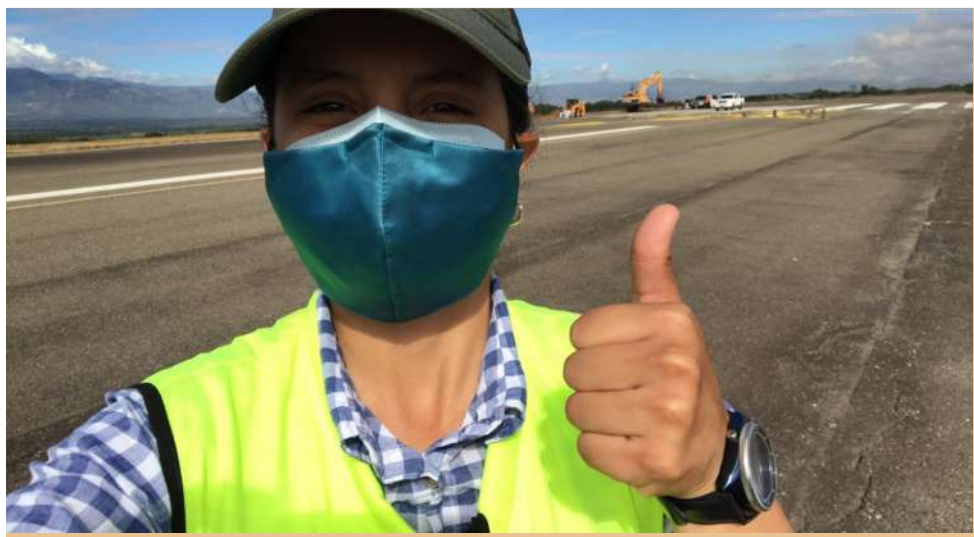
Ing. Mirna Gamero, Supervisión Eléctrica Aeropuerto Palmerola
