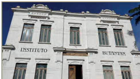
RESTAURO EDIFÍCIO VITAL BRASIL - Instituto Butantan - São Paulo - SP
