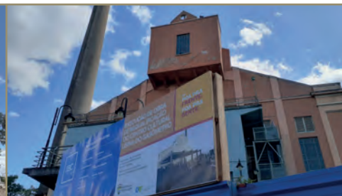
RESTAURO USINA DO GASÔMETRO Porto Alegre - RS
