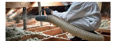
la ouate de cellulose ne peut être posée que par des souffleurs agréés, comme nous en avons chez Bamolux. Grâce à son élasticité et sa structure, la cellulose se comporte de la même manière que le bois massif en cas d'incendie, ce qui en fait **un matériau hautement résistant au feu en plus de repousser les insectes et les rongeurs.**
