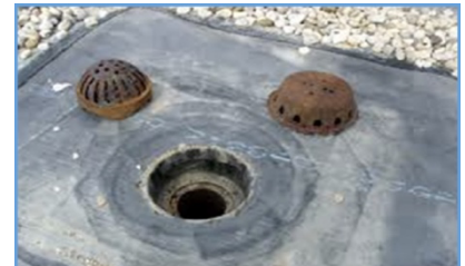
Desagüe de techo
