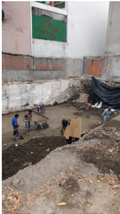
4) Se habilito área de desplante de losa fondo con el colado de plantilla de cemento y arena.
