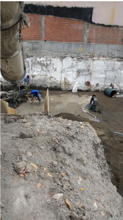
4) Se habilito área de desplante de losa fondo con el colado de plantilla de cemento y arena.
