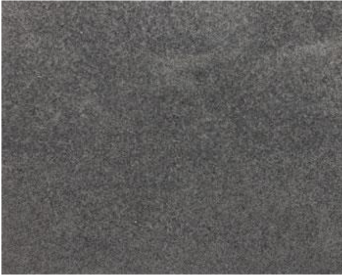
Muros exteriores en repellado cemento
