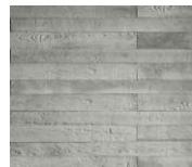
Muro de block a base de 2 capas, acabado final aparente concreto entablillado.
