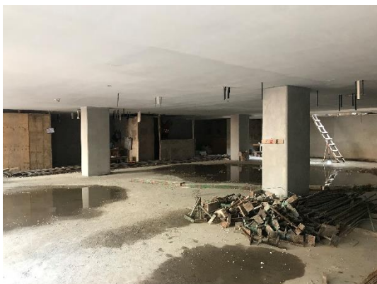
-Aplanado en losa y muros en nivel 1 de estacionamiento.
