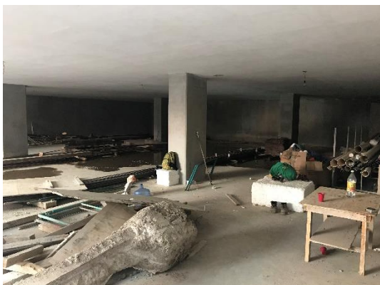
-Aplanado en losa y muros en nivel 2 de estacionamiento.
