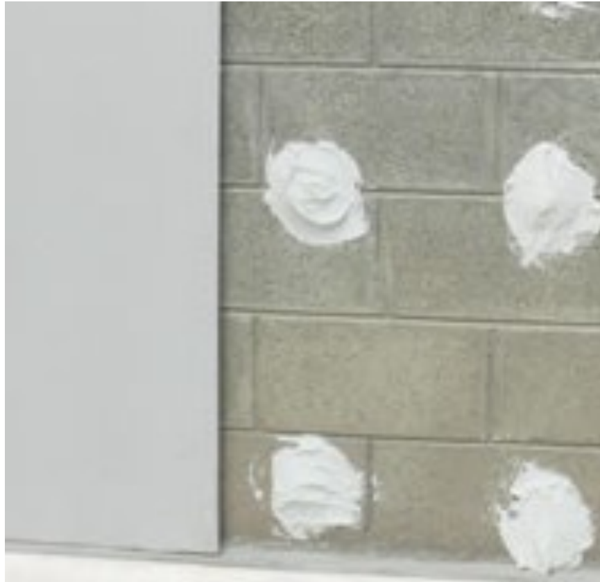
MUROS DE BLOCK CON APLANADO DE YESO ACABADA CON PINTURA BLANCA
