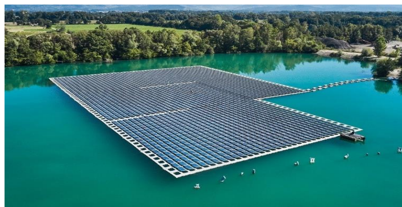
Figura 8. Imagen ilustrativa de sistemas fotovoltaicos flotantes [51].
