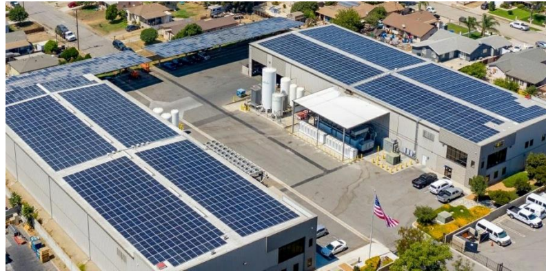
Figura 5. Imagen ilustrativa de sistemas fotovoltaicos comerciales.
