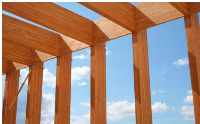
Structure en lamellé-collé. © Fibois.
