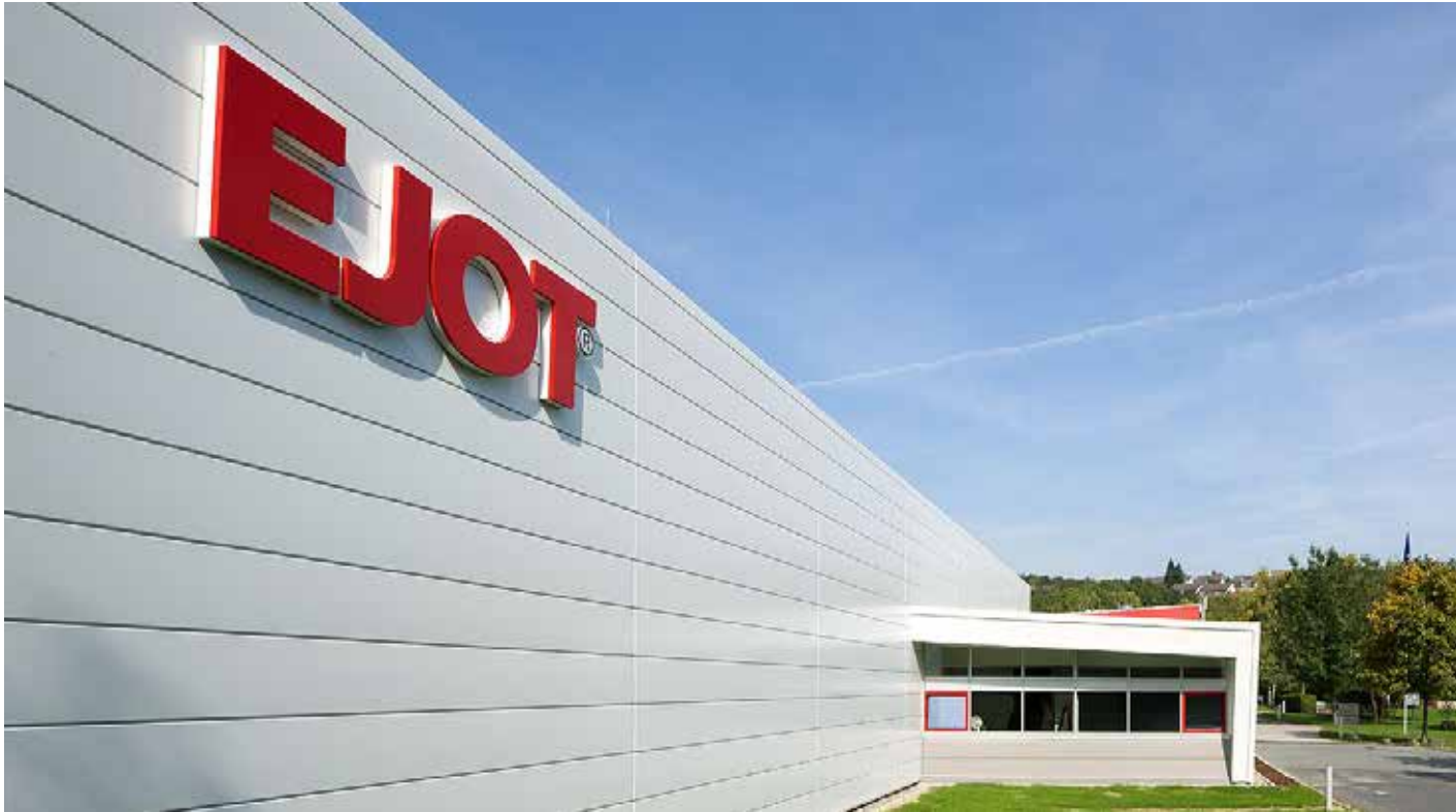
Bi-metalliruuvien tuotantolaitos, Bad Laasphe
