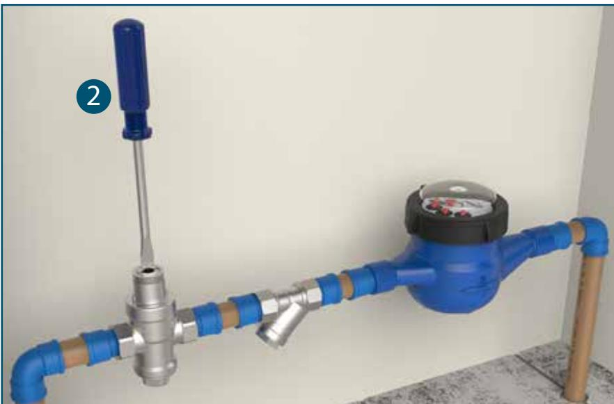
2. Com o auxílio de uma chave de fenda, regule a pressão da água girando o parafuso.
