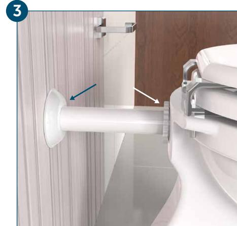
Por fim, posicione o vaso em definitivo e encaixe tubo na saída d'água e ajuste a canopla para fazer o acabamento. A outra extremidade do tubo acople à entrada d'água do vaso, apertando a porca até obter a vedação.
